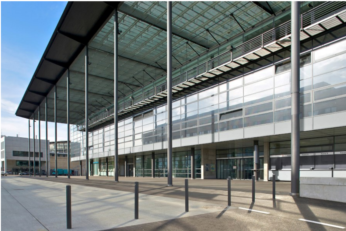
Messe Zürich | Anlieferungszone
